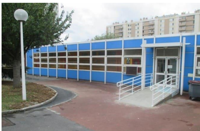
Porte de secours PMR
